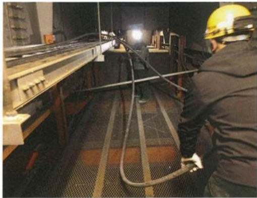
高配ケーブル張替作業
