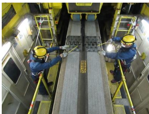
軌道設備の点検
