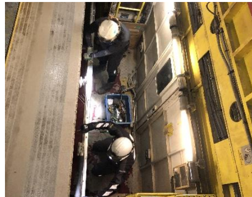
トロリー線（電車線）張替作業
