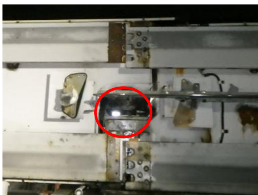
分岐器 T 形軸修繕（桁ジャッキアップ）
