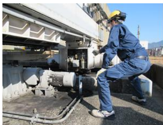
分岐器の点検
