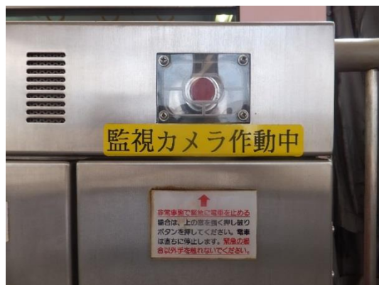
列車非常停止ボタン
