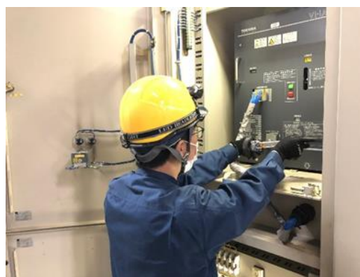
変電所設備の点検
