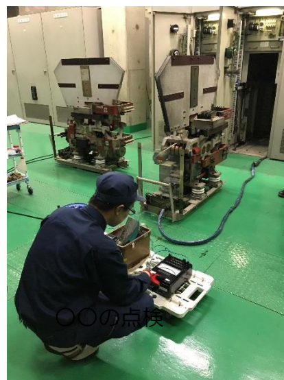
高速度遮断機の性能試験
