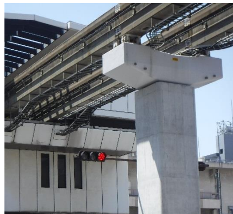
施工後(支柱が太くなっています)
