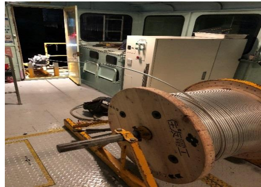
トロリー線（電車線）張替作業
