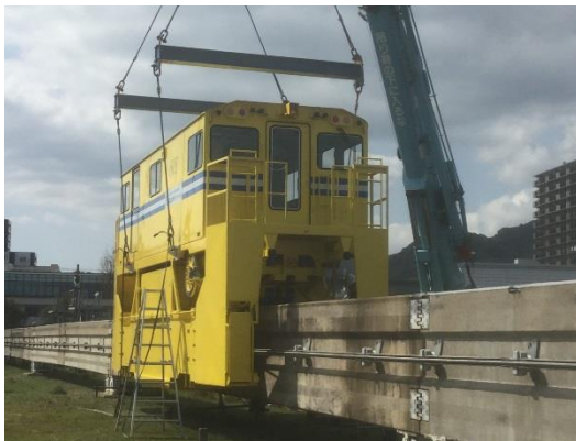
クレーンにより搬入
