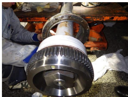
分岐器駆動装置取替
