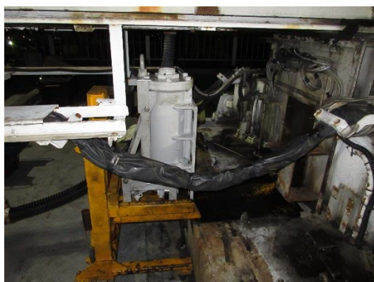
分岐器ロックシリンダー取替
