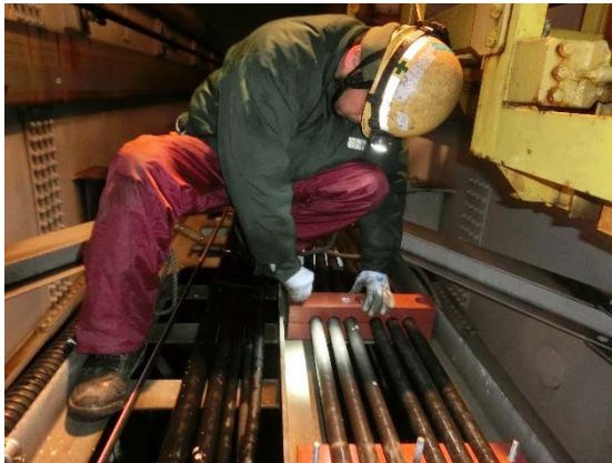
高圧ケーブル張替
