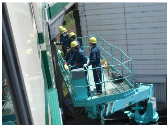
高所作業車による救出を開始
