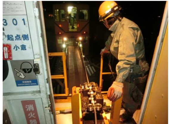
トロリー線（電車線）張替
