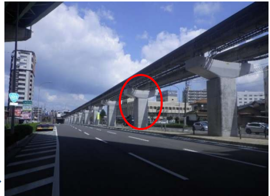
施工後（支柱が太くなっています）
