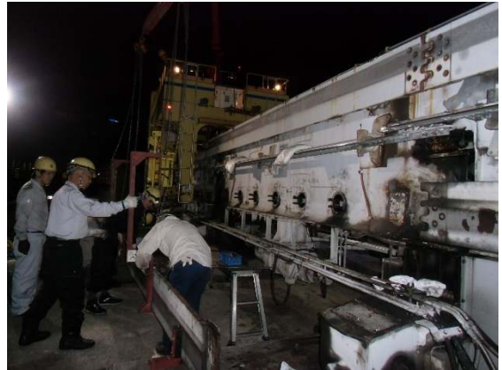
分岐器安定面補修
