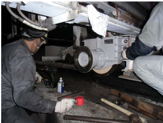
分岐器駆動装置取替
