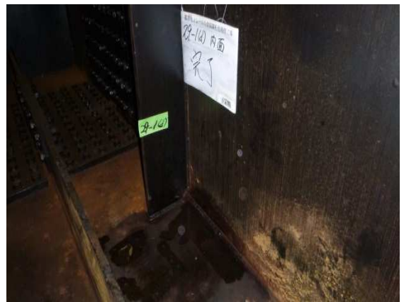
支柱内面塗替後
