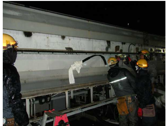
トロリー線（電車線）張替
