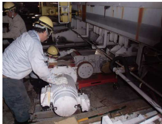
分岐器駆動装置取替
