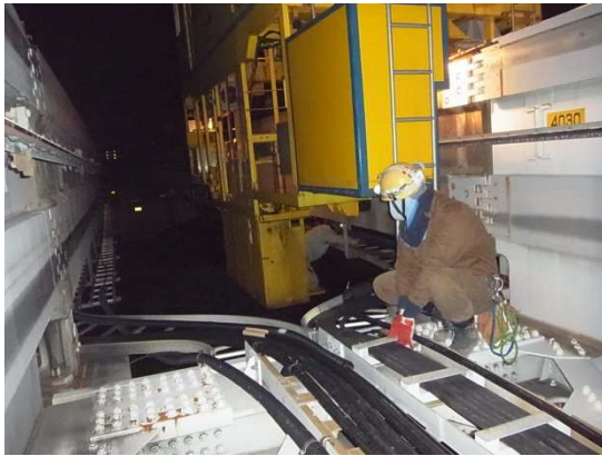
高圧ケーブル張替
