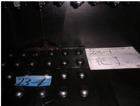
軌道桁内面塗替後
