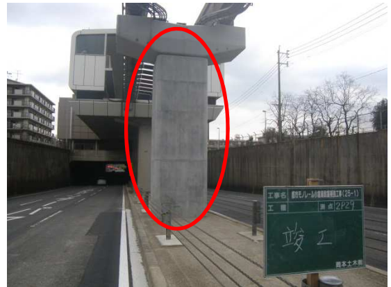
工事後(支柱が太くなっています)
