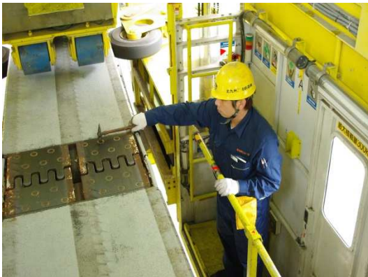
ボルト緩みの点検
